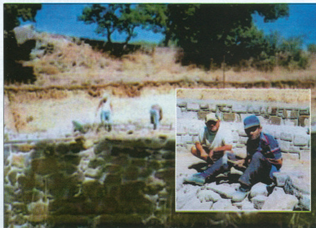
Κτίστες εργάζονται στις κερκίδες του αμφιθεάτρου (άνω), ενώ ο αρχιμάστορας Μενέλαος Κουπέ κάνει επίδειξη της τεχνικής του στο Χρήστο Παπουτσή (κάτω).
