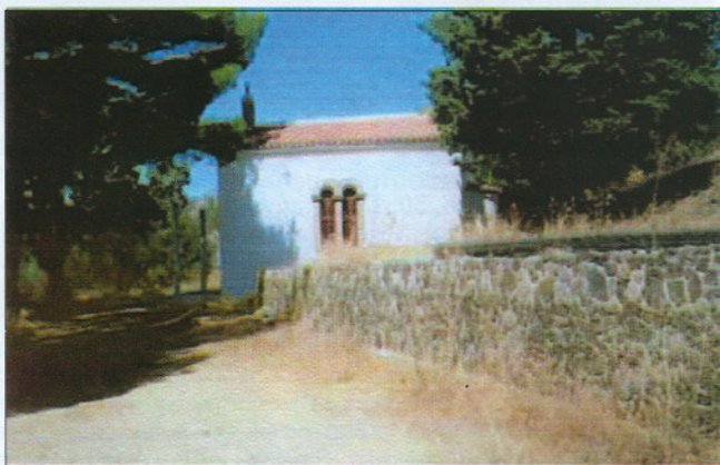
Ο δρόμος πρόσβασης που ισοπεδώθηκε για να χαθεί η κλίση εδάφους και ο υποστηρικτικός τοίχος από ντόπια πέτρα στο Πάρκο του Αγίου Νικολάου.
